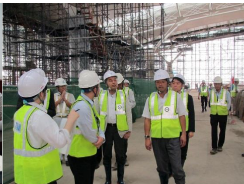
国際空港拡張工場の現場
